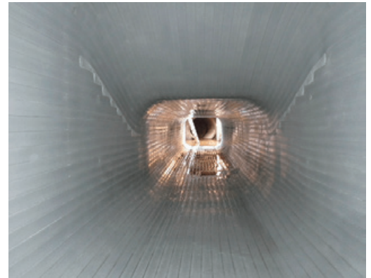
▲パルテム・フローリング工法
