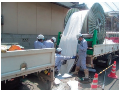
▲パルテムSZ工法
