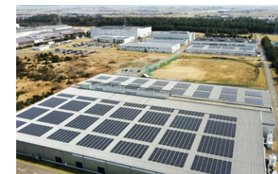
▲ TPF事業所に設置した太陽光パネル
