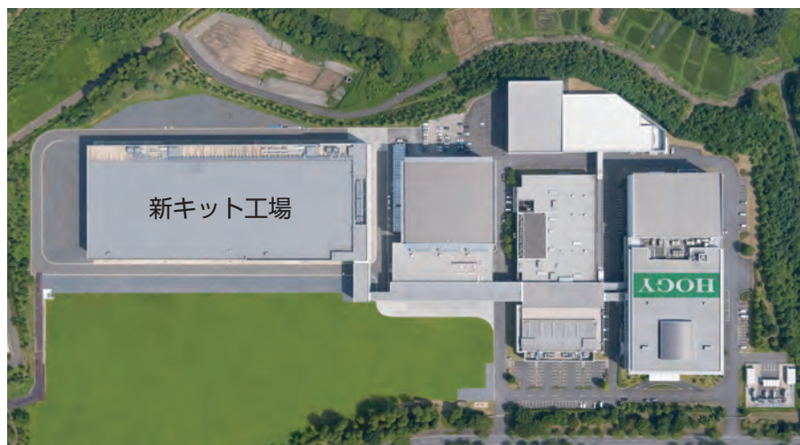
新工場を含む筑波工場全景
