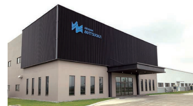
アンナム工場(第2期工場:2022年1月完成、第3期工場:2022年11月完成、第4期工場:2022年12月完成)
