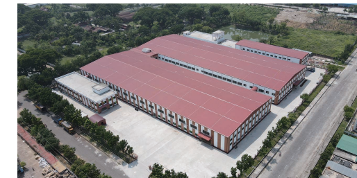
IMBD工場(第2期工場:2023年2月完成)
