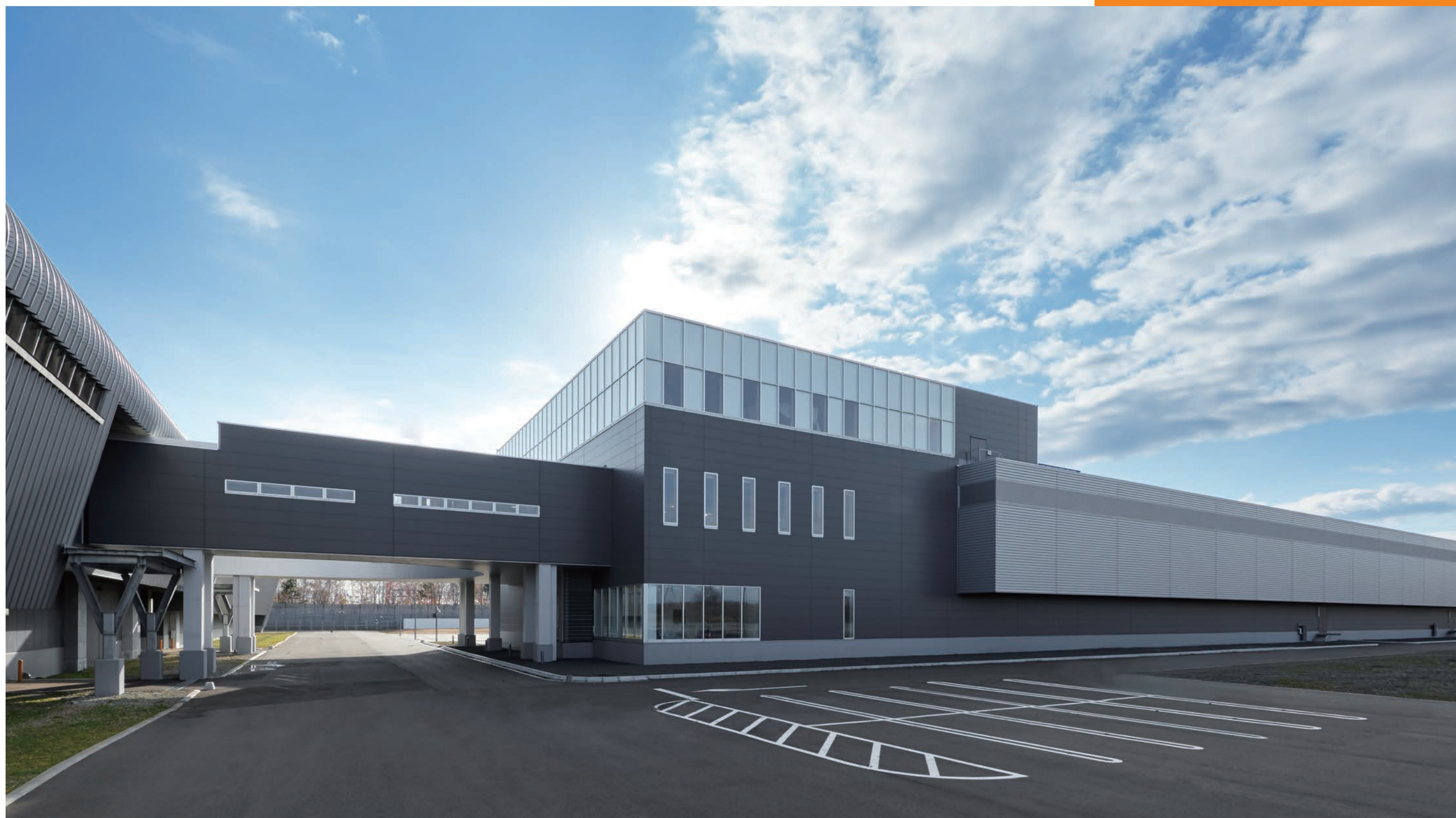
▲ 石狩データセンター 3号棟
