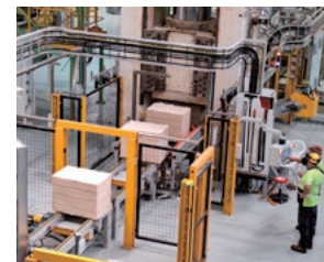
復旧稼働直後の工場パルプ設備
