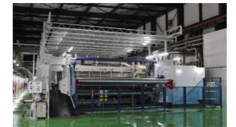
フィルムマシン2台を建設中の王子エフテックス滋賀工場(2023年3月-2024年11月稼働予定)
