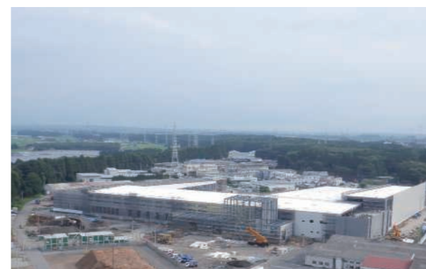
栃木県の段ボール一貫工場(建設中)
