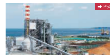
エム・ピー・エム・王子エコエネルギーバイオマス発電設備(19年9月営業運転開始)
