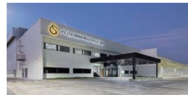
インドネシア 段ボール新工場
