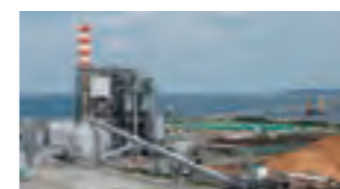
共同バイオマス発電事業(エム・ピー・エム・王子エコエネルギー) FIT制度に適応した国内最大規模のバイオマス発電所「八戸エコエネルギー発電所」の営業運転開始
