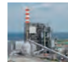
エム・ピー・エム・王子エコエネルギーのバイオマス発電設備
