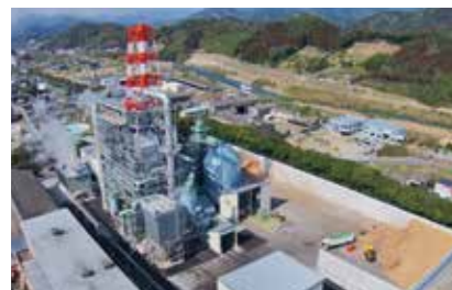
バイオマス発電所 (王子グリーンエナジー日南 / 宮崎県日南市)
