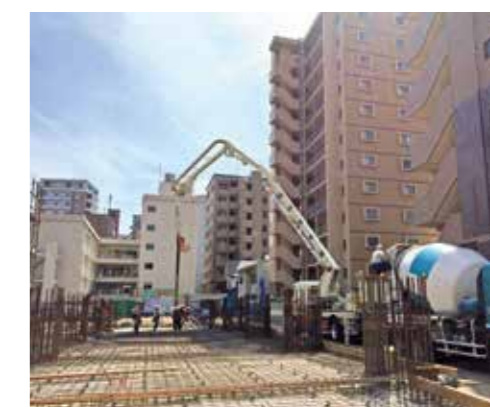
コンクリートポンプ車による圧送イメージ
