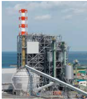
エム・ピー・エム・王子エコエネルギーのバイオマス発電設備
