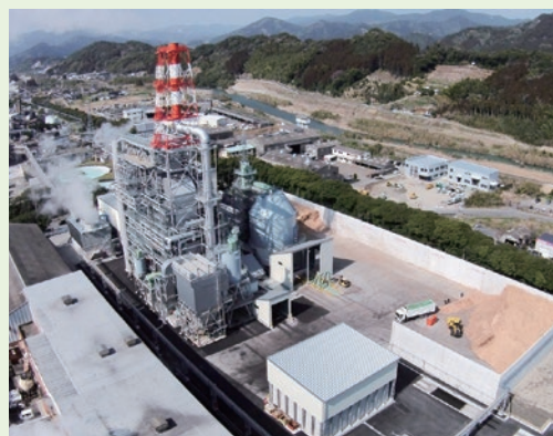
バイオマス発電所 (王子グリーンエナジー日南/宮崎県日南市)
