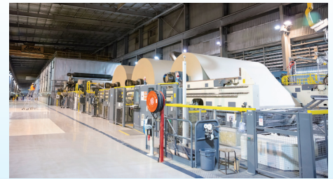
段ボール原紙製造設備
