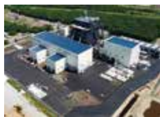
建設中の勇払エネルギーセンター
