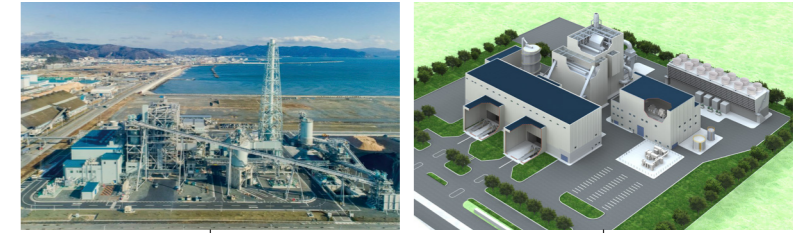
左:石巻雲雀野発電所 右:勇払エネルギーセンター(完成イメージ)
