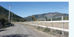
設置したフェンス
