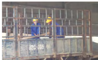
作業安全の確認(ヘルメット着用等)
