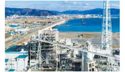
石巻雲雀野発電所
