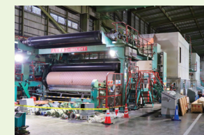
改造工事中の新潟工場6号抄紙機
