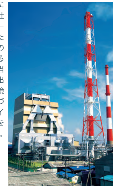
新潟工場8号回収ボイラー
