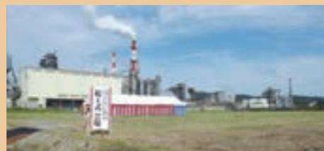
マップカ新工場建設予定地
