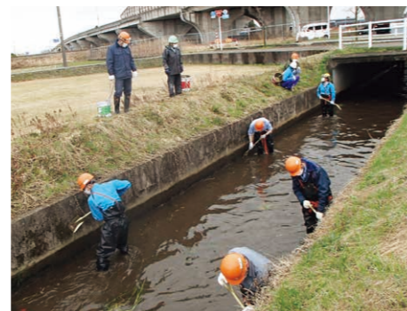
桜川清掃の様子
