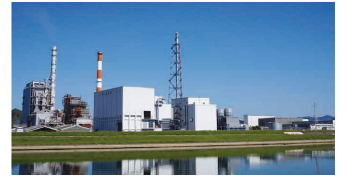
川内工場 木質バイオマス発電設備
