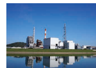
木質バイオマス発電設備(川内工場)
