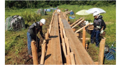
木道の架け替え工事
