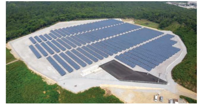
唐浜メガソーラー発電所
