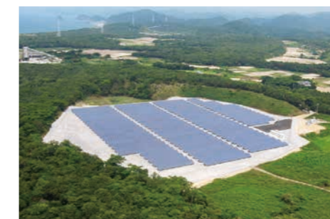
唐浜メガソーラー発電所
