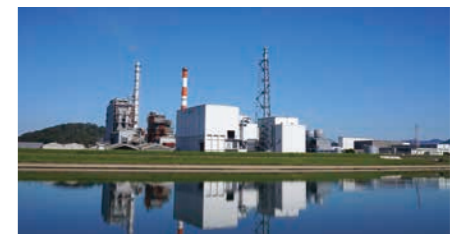
川内工場・木質バイオマス発電設備
