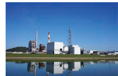
木質バイオマス発電設備
