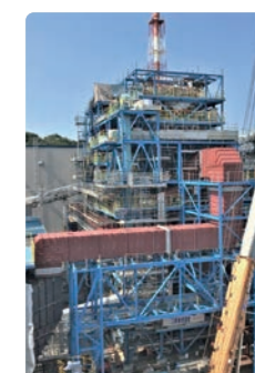
いわき大王製紙で建設中のリサイクルボイラー
