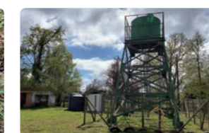
ロス・リスコス地区の学校敷地内に設置された貯水タンク(2基)
