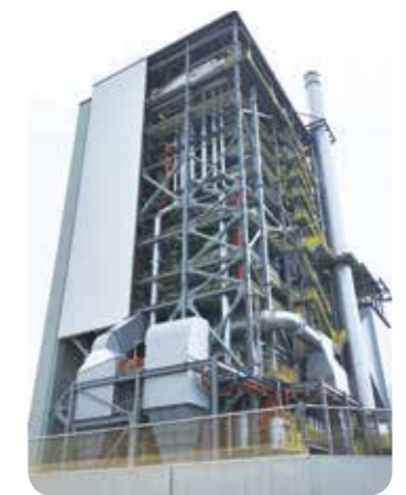
三島工場FIT制度を活用したバイオマスボイラー
