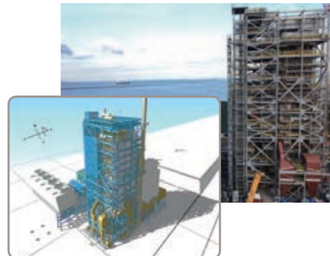
建設中のFITバイオマスボイラー（右上）と完成予想図（左下）
