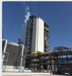
三島 FITバイオマス発電用ボイラー
