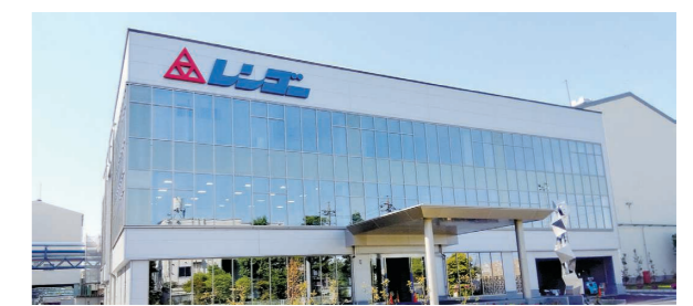
八潮工場 新事務所棟
