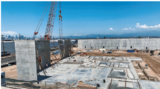
拡張工事中のサウスランドボックス社
