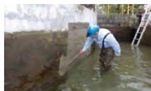
湿潤面補修材の試験施工の様子(東長原事業所 旭ダム系水路の壁面補修)
