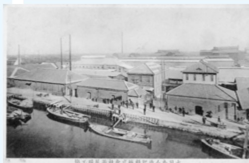
原料の搬入、製品の搬出に際し水利の便が良い、現在の東京都江東区大島1丁目、通称「釜屋堀」の土地が選定され、1888年に過燐酸石灰(肥料)の製造を開始
