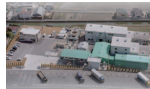
熊山工場 長船分工場(敷地面積:9,300㎡) 所在地:岡山県瀬戸内市長船町長船1239-1
