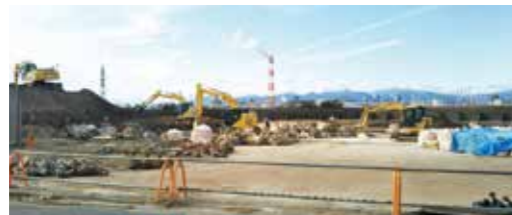
2018年 撤去作業中
