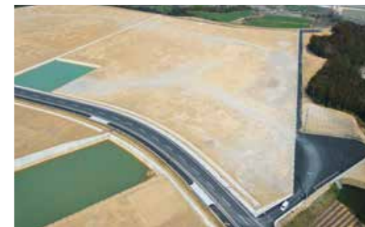
小野研究所の建設予定地
