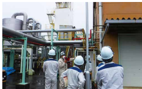
四日市工場 経営層による保安査察
