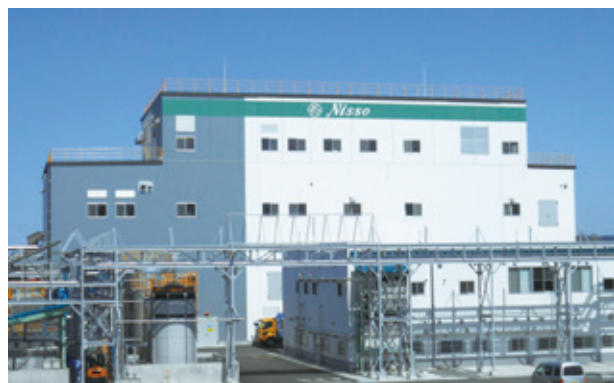
二本木工場 増産設備
