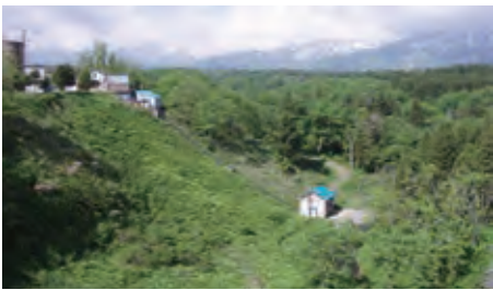
二本木工場の小水力発電設備
