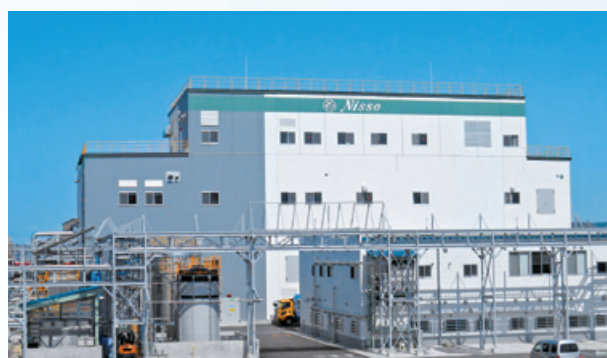
二本木工場 HPC増産設備
