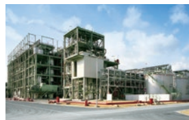
MDI製造設備
