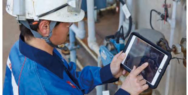
タブレット端末を通じて、プラントの運転をコントロールする計器室と音声だけでなく、映像も含めた情報共有・コミュニケーションが可能になります。
