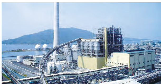
自家発電設備
