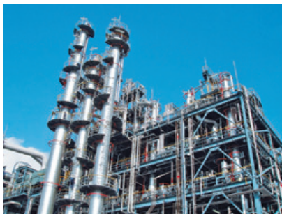
▲エチレンアミン製造設備
