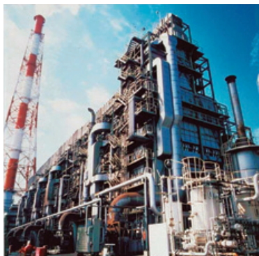
▲エチレン製造設備
