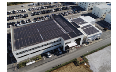
太陽光パネルを設置した鹿島工場の建屋
