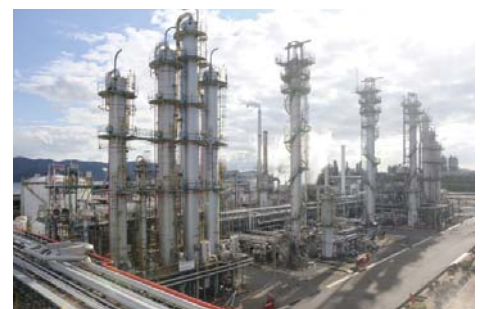
イソプロピルアルコール製造プラント
