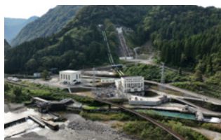
新姫川第六発電所（2022年送電開始）
