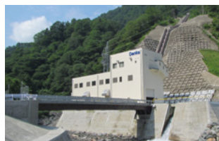
新青海川発電所（2021年送電開始）
