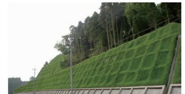
GTフレーム工法®によるのり面
