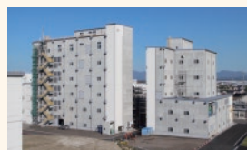
完成したメトロース®の新工場
