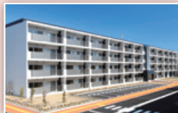
アルミ手摺施工例
