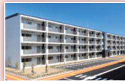
アルミ手摺施工例
