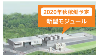
▲ 当社・東濃インターネットデータセンター
