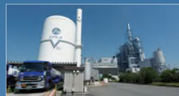
発電所に隣接する産業ガス製造プラント
