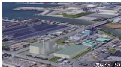
木質バイオマス専焼発電 発電能力 約7.5万kW（2021年4月稼働開始予定）
