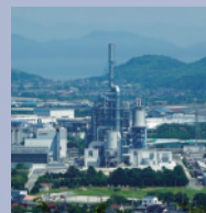
エア・ウォーター&エネルギー・パワー山口
