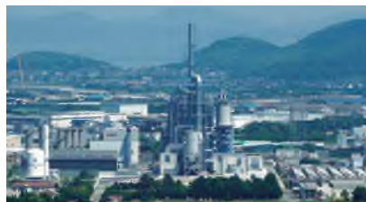
木質バイオマス・石炭混焼発電 発電能力 約11.2万kW（2019年7月稼働開始）
