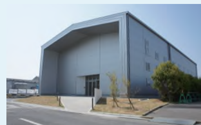
振動試験を行う、エア・ウォーター 防災「振動試験センター」
