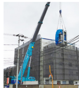
不溶性硫黄の新プラント建設工事
