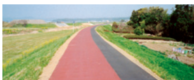
▲ カラー舗装用着色顔料施工例
